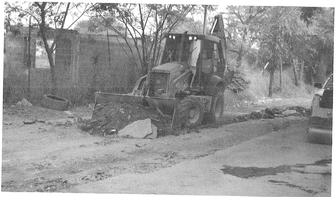
La maquinaria continuará trabajando y limpiando áreas y caminos vecinales.
